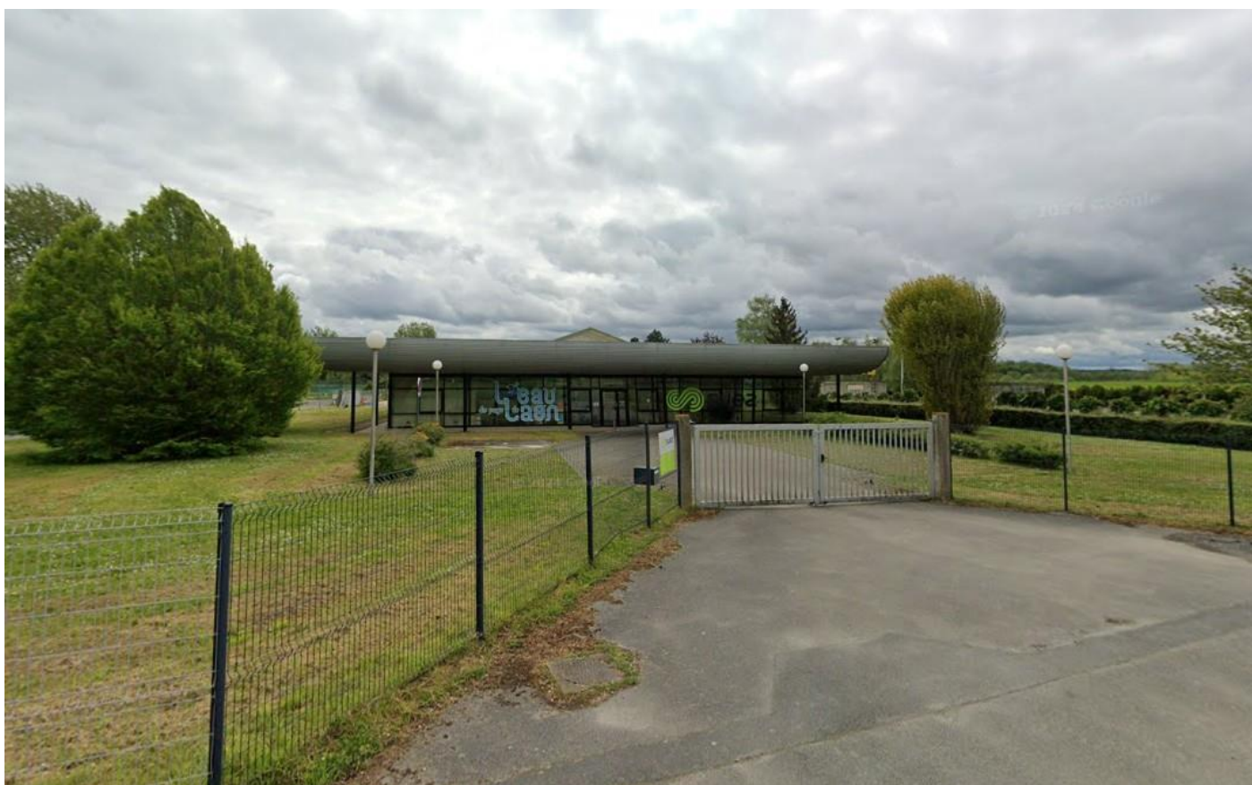
Bâtiment du service des eaux de Laon
