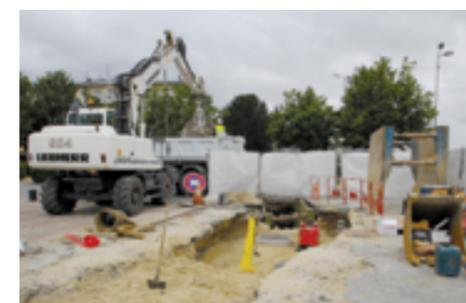
Cet été, les réseaux électriques et les branchements plomb d'eau potable ont été repris place des Droits de l'Homme. Au niveau du rond point, c'est un puits microtunnelier qui a été réalisé afin d'effectuer une partie de ces travaux en réduisant les nuisances aux riverains et utilisateurs.
