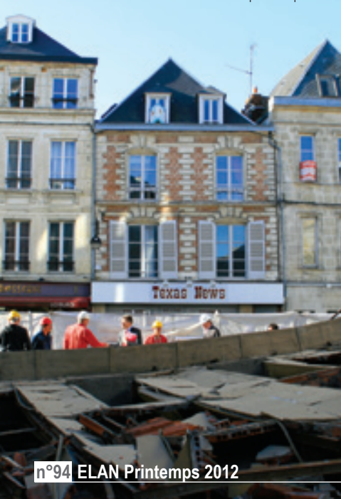
Démolition du Monoprix - Sept. 2011
